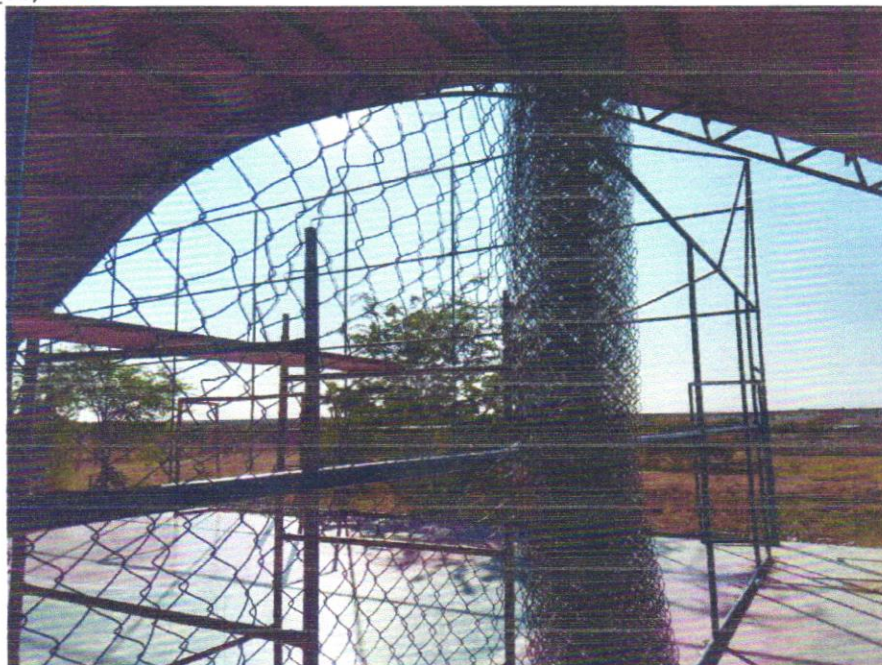
Foto 06 - ALAMBRADO PARA QUADRA POLIESPORTIVA, ESTRUTURADO POR TUBOS DE ACO GALVANIZADO, (MONTANTES COM DIAMETRO 2", TRAVESSAS E ESCORAS COM DIÂMETRO 1 ¼ ), COM TELA DE ARAME GALVANIZADO, FIO 10 BWG E MALHA QUADRADA 5X5CM (EXCETO MURETA). AF_03/2021
