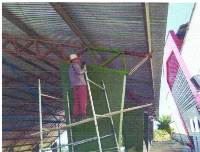
FOTO 01 – PINTURA DE ACABAMENTO COM APLICAÇÃO DE 02 DEMÃOS DE ESMALTE SINTÉTICO SOBRE SUPERFÍCIES METÁLICAS - R1
