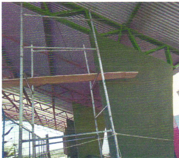
Foto 08 - PINTURA DE ACABAMENTO COM APLICAÇÃO DE 02 DEMÃOS DE ESMALTE SINTÉTICO SOBRE SUPERFÍCIES METÁLICAS - R1
